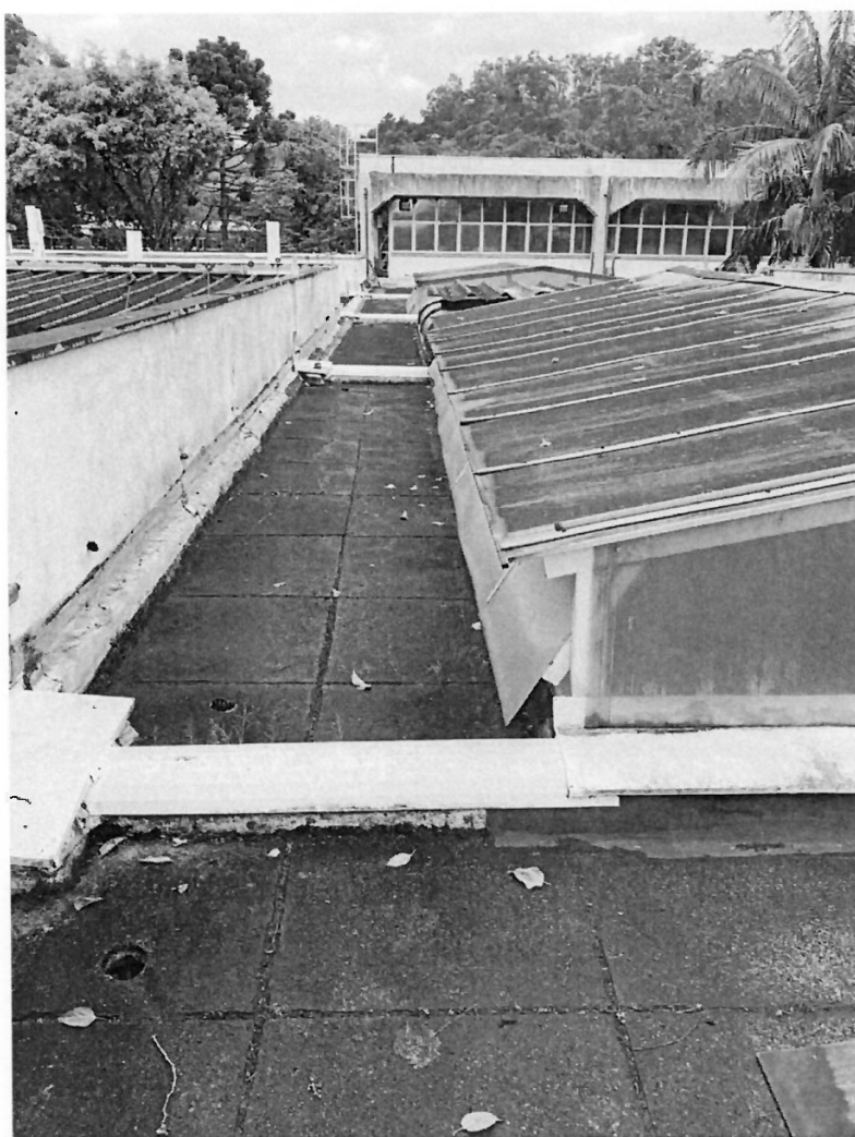
Figura 1 – Vista da cobertura do IGc
