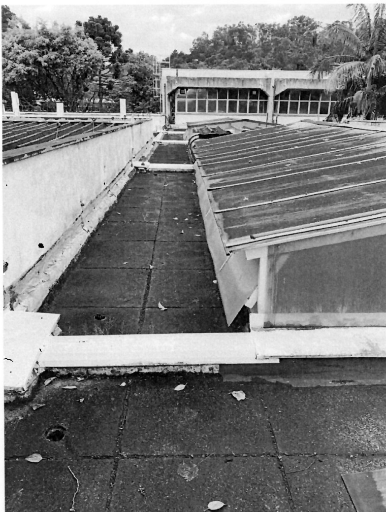
Figura 1 – Vista da cobertura do IGc
