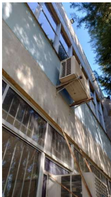
Foto 6: Exemplo de local de instalação na parede externa no piso 1 (similar ao piso térreo)
