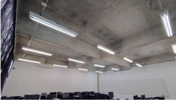
Foto 7: Exemplo de local de instalação dos aparelhos do tipo cassete
