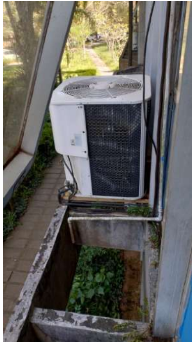
Foto 5: Exemplo de local de instalação no brise do piso 1
