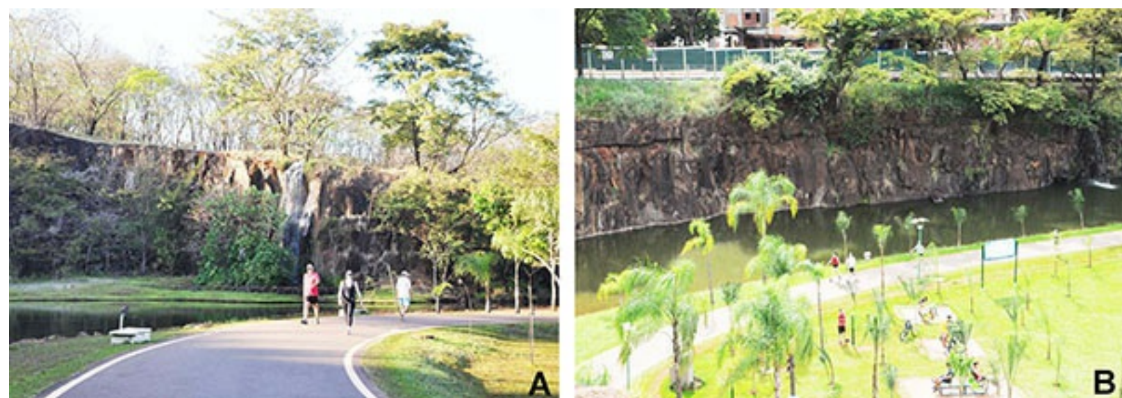
Figura 8 - Pedreiras de basalto desativadas na cidade de Ribeirão Preto (SP) transformadas em parques municipais. A. Parque Prefeito Dr. Luiz Roberto Jábali, mais conhecido como Parque Curupira. B. Parque Municipal Dr. Luis Carlos Raya. Fotos: Lauro Kazumi Dehira.
