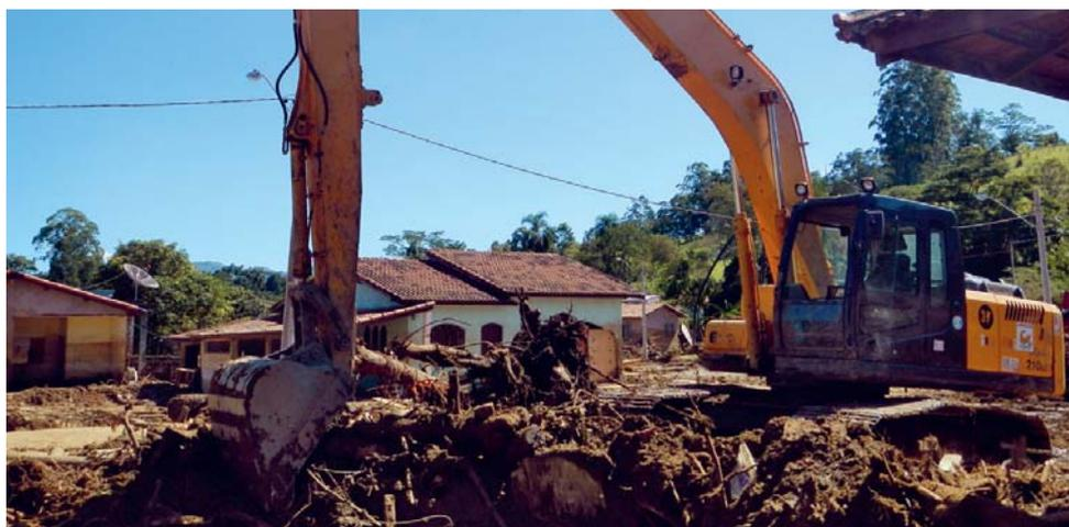
*Imagem 6.3 - Itaóca (2014) - Maquinários contratados emergencialmente para emprego na limpeza e desobstrução de vias após inundações*
